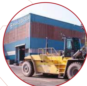
MARCEGAGLIA PALINI E BERTOLI PLANT San Giorgio di Nogaro (UD)
